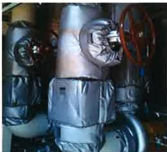
表面・裏面材: ガラスシリコンクロス、断熱ガラスクロス、ガラスステフロンクロス、シリカクロス
